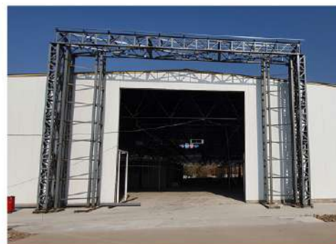
Фасад и кровля
